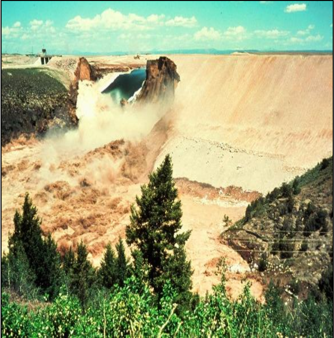
الشكل (12-2) فتحة الانهيار في سد teton
