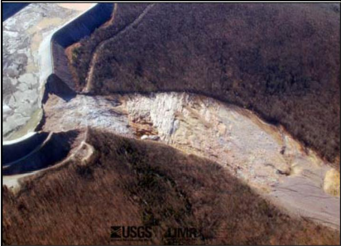
الشكل (10-2). فتحة الانهيار في سد Taum Sauk
