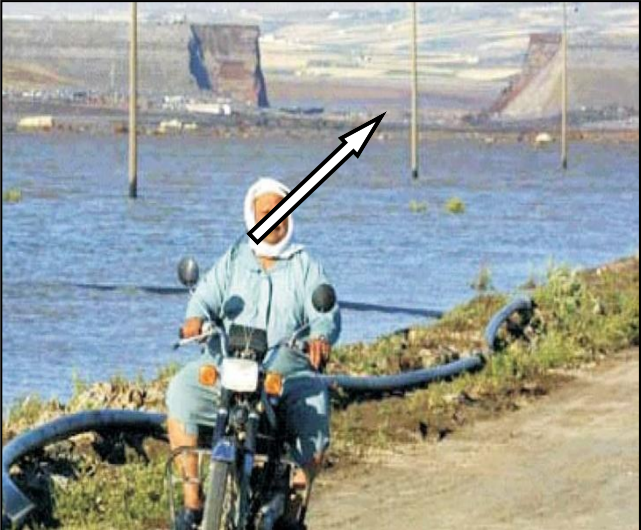
الشكل (8-2). شكل فتحة الانهيار في سد زيزون
